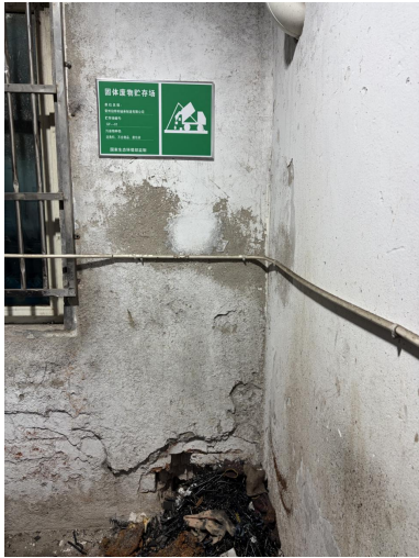
一般固废堆放场
